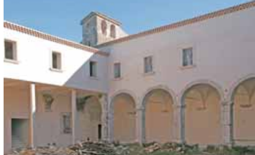
Il Convento oggi in fase di ristrutturazione e ricostruzione
