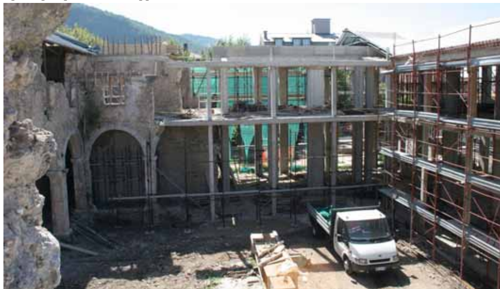
Lavori di ristrutturazione-ricostruzione del Convento S. Antonio
