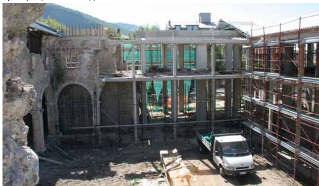
Lavori di ristrutturazione-ricostruzione del Convento S. Antonio
